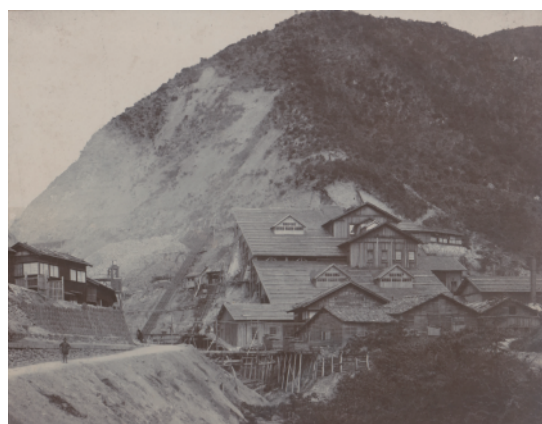
尾小屋鉦山選鉦場外部之景(明治42年頃)
