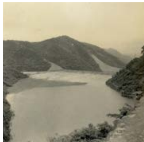
かつての沈殿池
