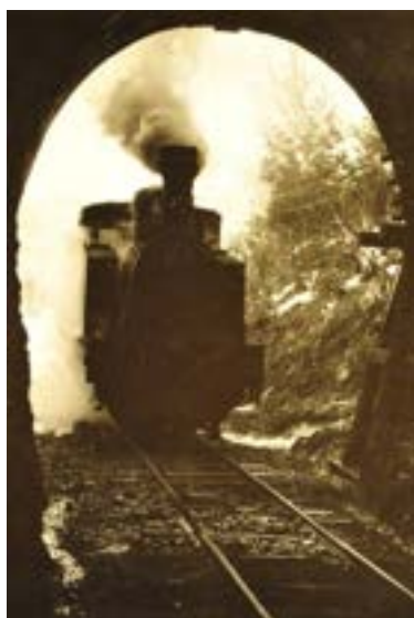
倉谷隧道へ入る5号蒸気機
